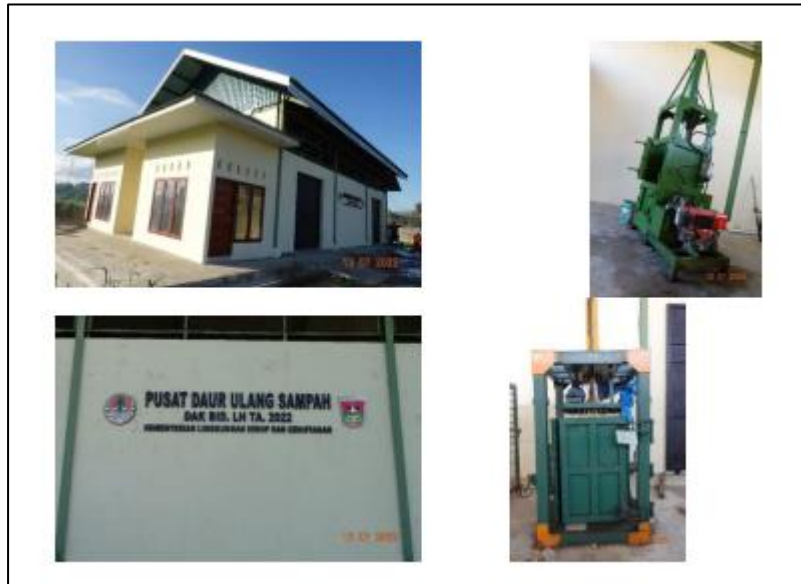
Gambar 3.69 Gambar Pusat Daur Ulang (PDU) Dinas Lingkungan Hidup Kota Bukittinggi
